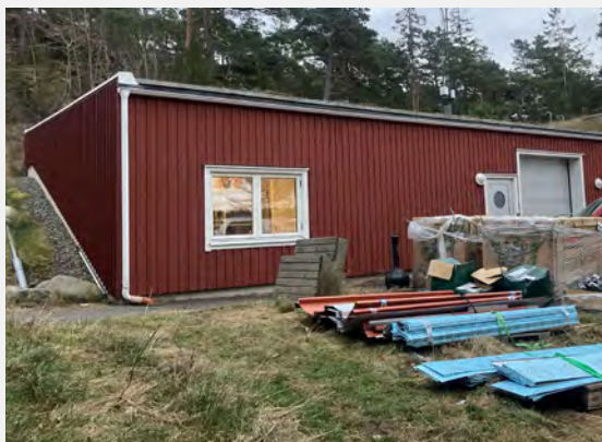
Förrådet mellan förläggningarna i anslutning till plan parkeringsyta
