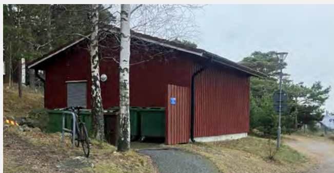
Ställverket är en röd teknikbyggnad mellan Matsal och Vita förläggingsbyggnaden
